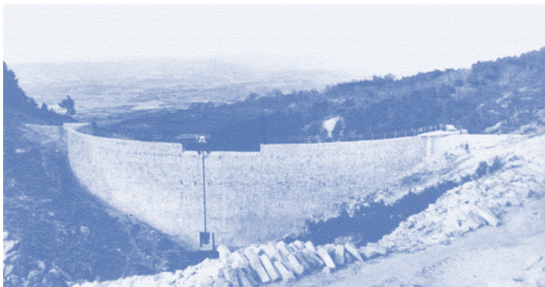
Figura 28. Barragem na ribeira do Melo.
