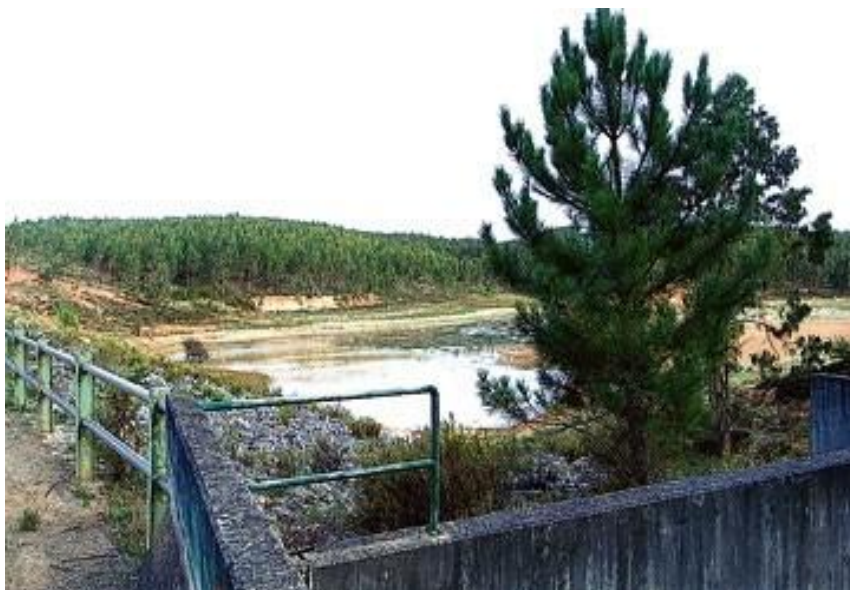
Figura 34. Barragem da Sobrena.
