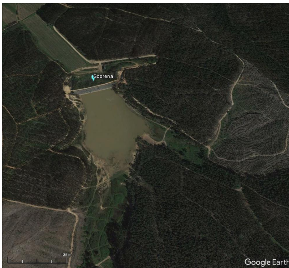
Figura 33. Localização do açude da Sobrena (Google Earth).
