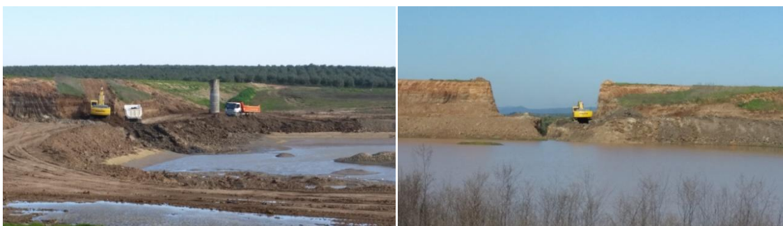
Figura 7 – Aspetos sequenciais do processo de remoção da barragem da Sardinha.
