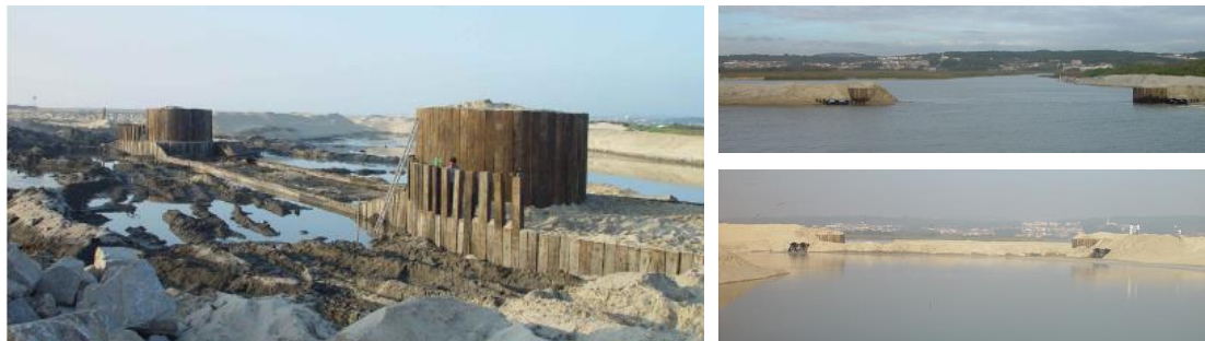
Figura 8.31 Dique fusível da Barrinha de Esmoriz com pormenores na fase de construção e com a ligação ao mar aberta e encerrada (fonte: ARH Centro)
