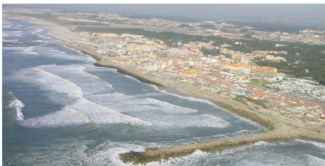
Figura 8.19 Defesa frontal de Esmoriz sem praia em frente à obra
